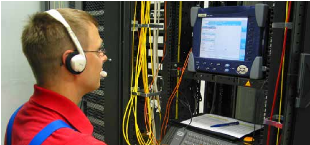
Künftig soll die Realisierung kritischer Netzwerke für öffentliche und weitere industrielle Auftraggeber ausgebaut werden. © ISIMKO
