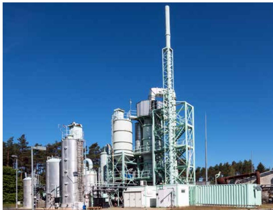
Umbau einer Bestandsanlage für thermische Vorbehandlung des Batterierecyclings. Foto: Spreewerk Lübben GmbH
