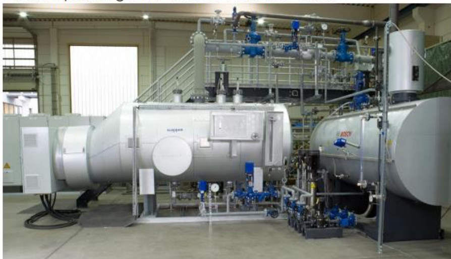
Sattdampferzeuger mit externer Überhitzer-Stufe
